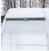
Панель сдвижная предназначена для проветривания теплицы и исключения снеговой нагрузки на каркас теплицы. Сдвигается при помощи удобной ручки в одну или другую сторону по всей высоте теплицы.
